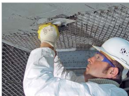
1. Trabalhos em áreas suspensas são perfeitamente possíveis
