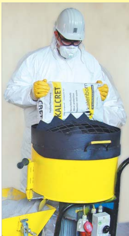
Colocação do KALCRET no sistema de projeção Kalenborn
