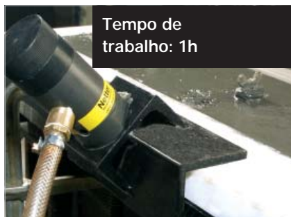
4. Use vibrador externo para compactar
