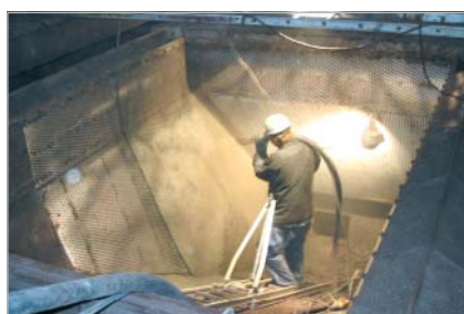
Revestimento de uma caixa de vento abaixo do sinterizador em uma aciaria
