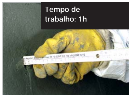
4. Verificar a espessura da camada e nivelar, se necessário
