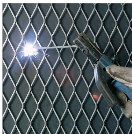
Soldagem da chapa expandida na superfície: distância de aproximadamente 250 mm
