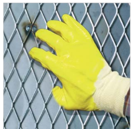
Amarração reforçada e rígida – distância da superfície a ser revestida: cerca de 5 mm
