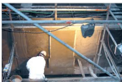
Revestimento de uma parede de impacto em uma coqueria
