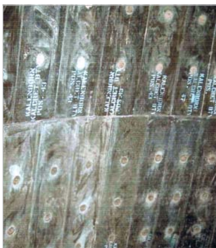
Elementos moldados pré-fabricados, exemplo para revestimento de ciclone
